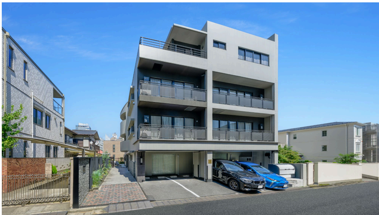
KYŌ RESIDENCE 新宿代々木完成外観
